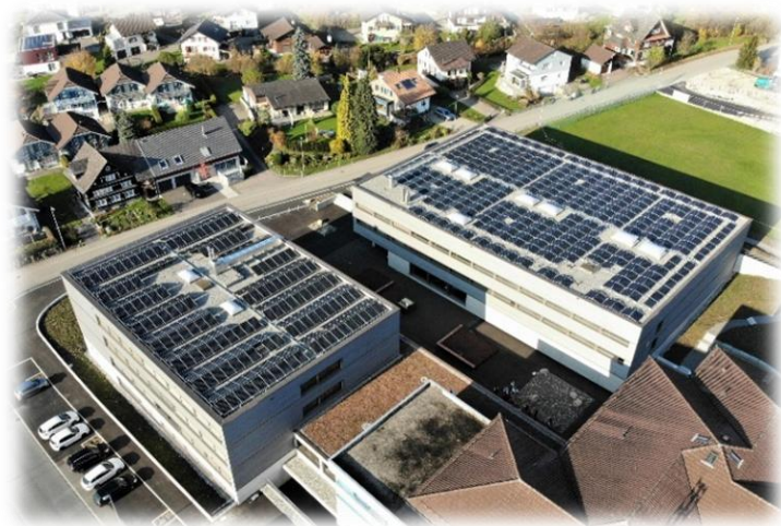
Unsere Photovoltaikanlage auf den Dächern der Schulanlage Wier / Foto: Energiefabrik AG
