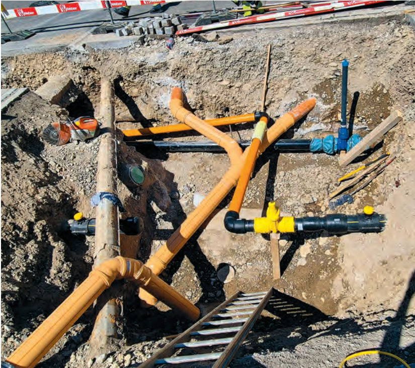
Bild links: Ballungspunkt von diversen Werkleitungen Kreuzung Sonnegg- / Ebnaterstrasse mit Wasser-, Abwasser-, Elektro- und Gasleitungen.
